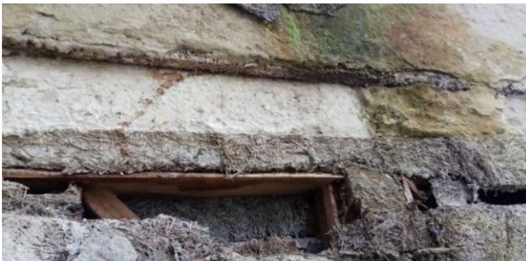
Fig.3 Struktura horizontale që lidh kolonat
